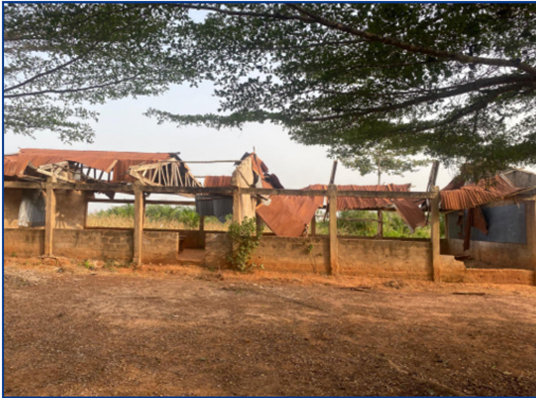
Salles de classes avant la rénovation
